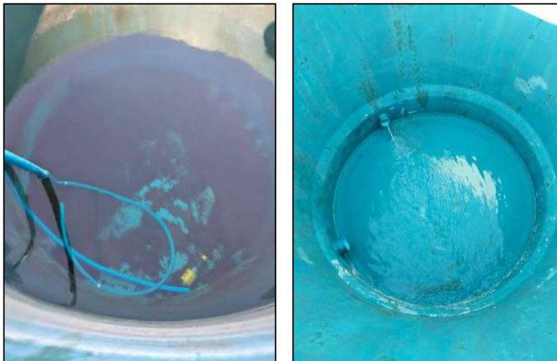
รูปภาพที่ 2.27 การล้างทำความสะอาดถังเก็บน้ำสำรอง
